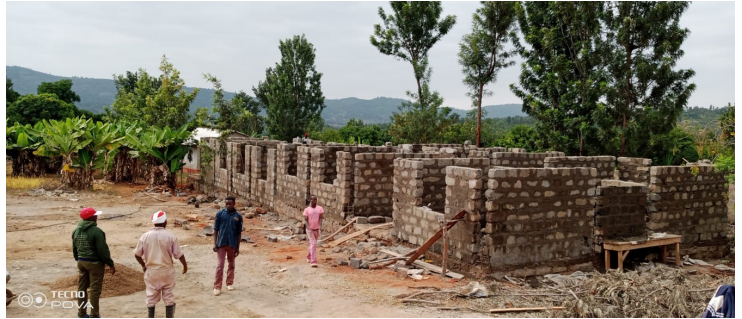
Bau der Mädchenschlafräume, Stand Juni 2022
